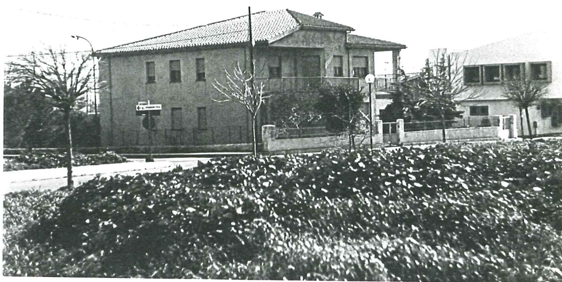
PROSPETTO SU VIA IV NOVEMBRE unità a
