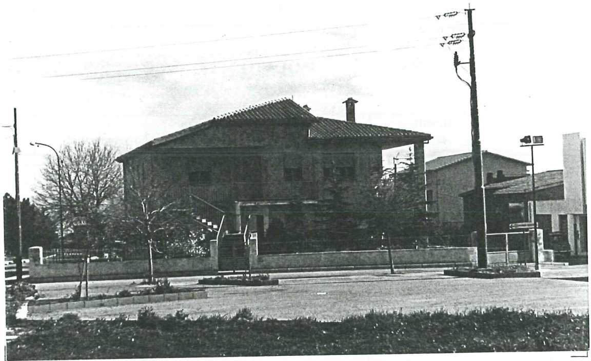
PROSPETTO SU VIA IV NOVEMBRE unità a
