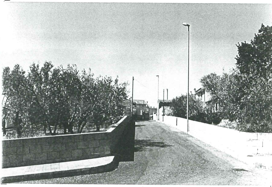
PROSPETTO SU VIA UMBERTO I°
